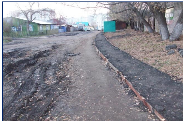
СИЛАМИ ЖИТЕЛЕЙ ТОС НА ОДНОЙ ИЗ УЛИЦ СМОНТИРОВАНА АСФАЛЬТОВАЯ ТРОТУАРНАЯ ДОРОЖКА
